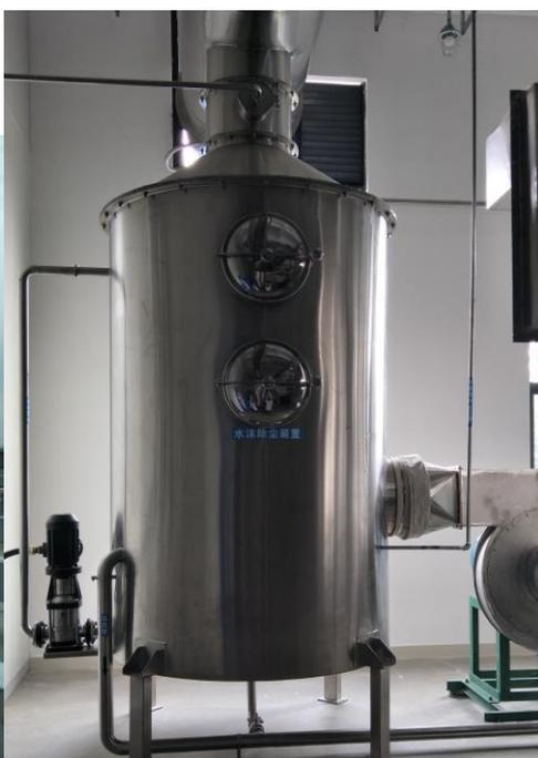
喷雾干燥塔尾气水膜除尘装置
